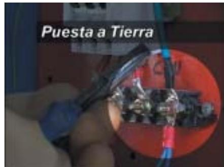
5. El Sistema de PAT será eléctricamente continuo y tendrá la capacidad de soportar la Corriente de Cortocircuito Máxima coordinada con las protecciones instaladas en el circuito.
